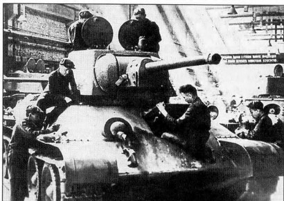
Т-34 с шестигранной башней собирают на Уральском заводе транспортного машиностроения (УЗТМ)
