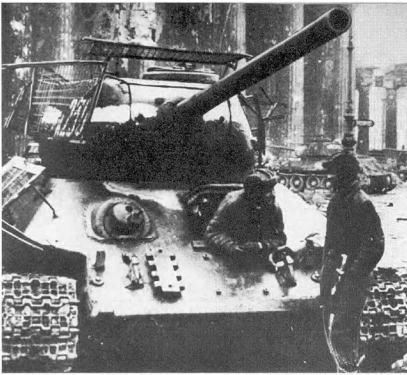
Для защиты от "фаустпатронов" на Т-34 часто устанавливались специальные экраны из сеток
