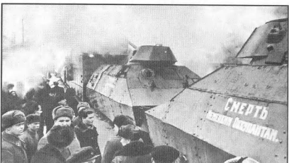
Башни Т-34 часто ставили на бронепоезда, а этот бронепоезд "Смерть немецким оккупантам" вообще сделан из корпусов Т-34
